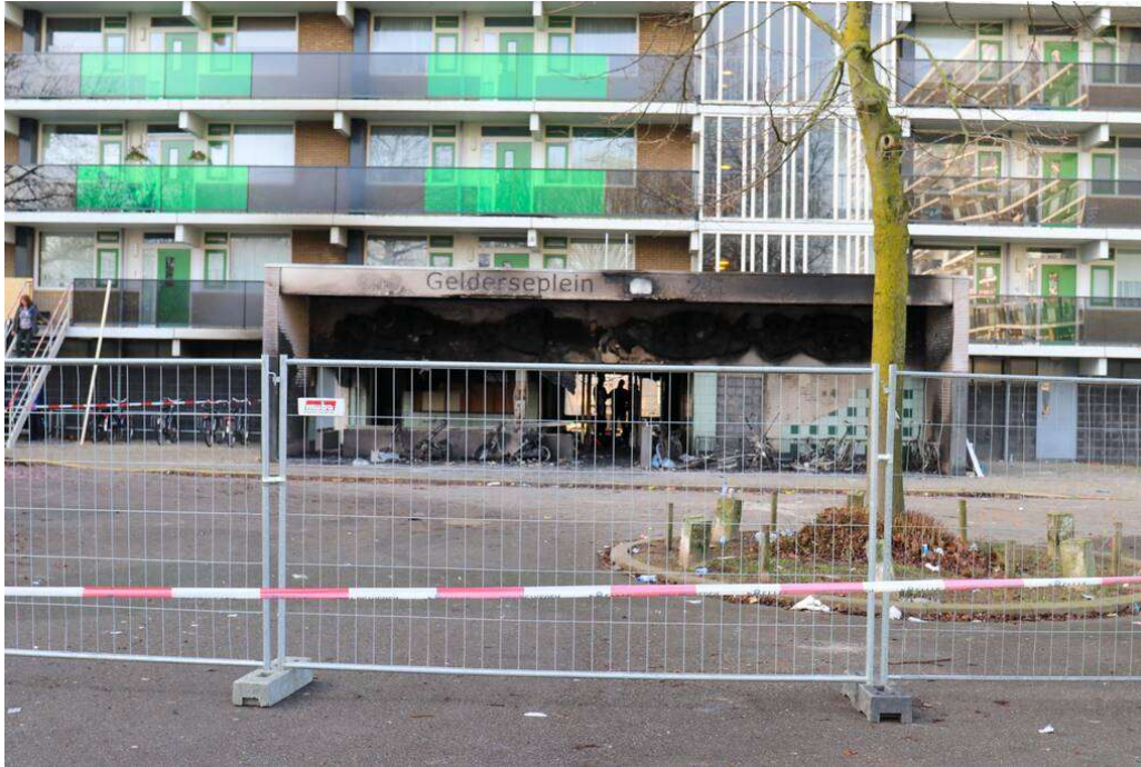
Figuur 1: Entree galerijflat Gelderseplein te Arnhem na de brand
